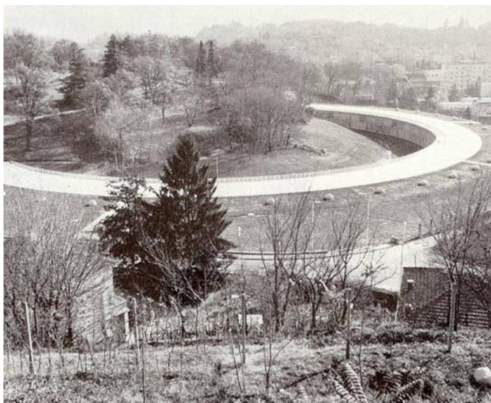
1. R. Gabetti, A. Isola con L. Re, Centro residenziale Olivetti , Ivrea, 1968-71
